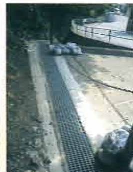
グレーチング設置(羽黒町)
