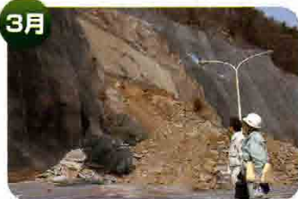
崩落現場や他の危険箇所の確認、早期復旧を要請
