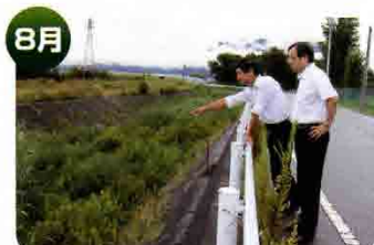
草が生い茂り流れが悪くなっている河川を視察
