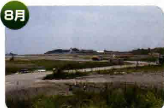
建設中の富士山静岡空港を視察
